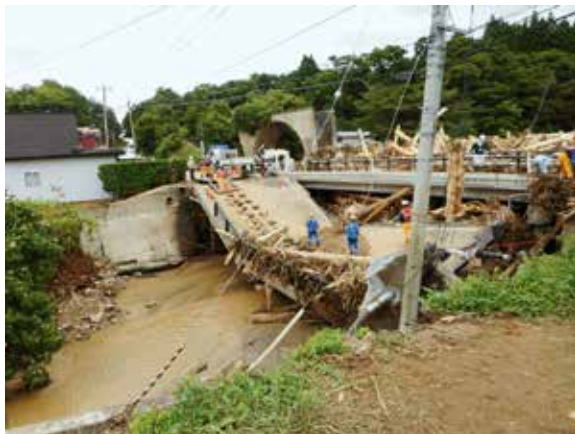
橋が崩壊して孤立する世帯が発生
