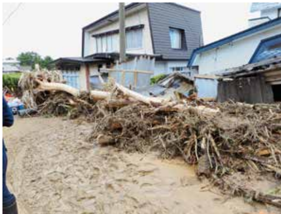
流木等の漂流物により住宅が破損
